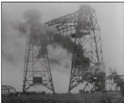
Op 9 september 1944 wordt de brug geraakt bij een luchtaanval.
